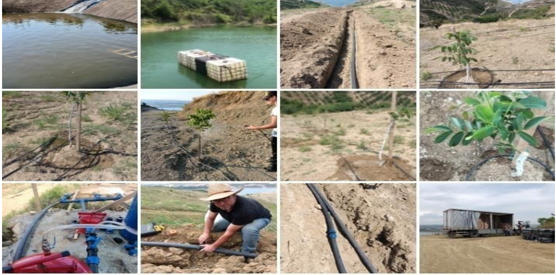
Şekil 4.7 Sulama, damlama sistemi kurulma işlemleri
